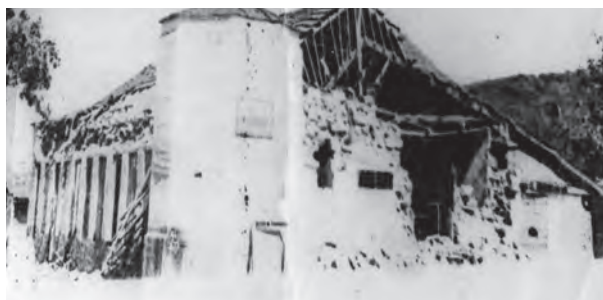
Здание клуба после землетрясения. 1973
